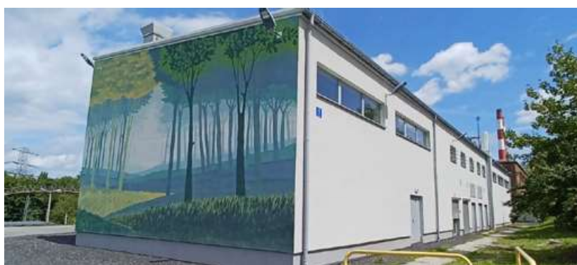
Budynek kotłowni gazowej
