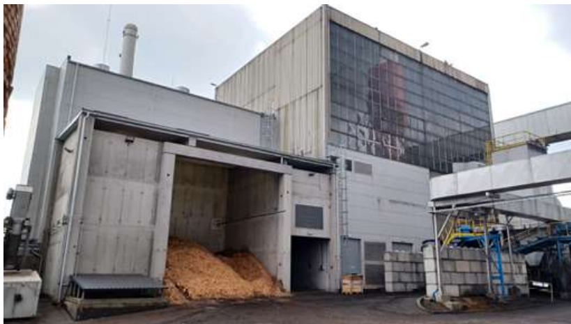
Budynki kotłowni biomasowej i węglowej
